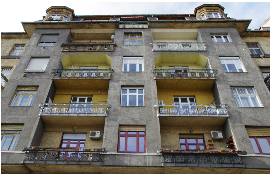
20. ábra: Bálint és Jámbor bérpalotájának homlokzata a Műegyetem felől
