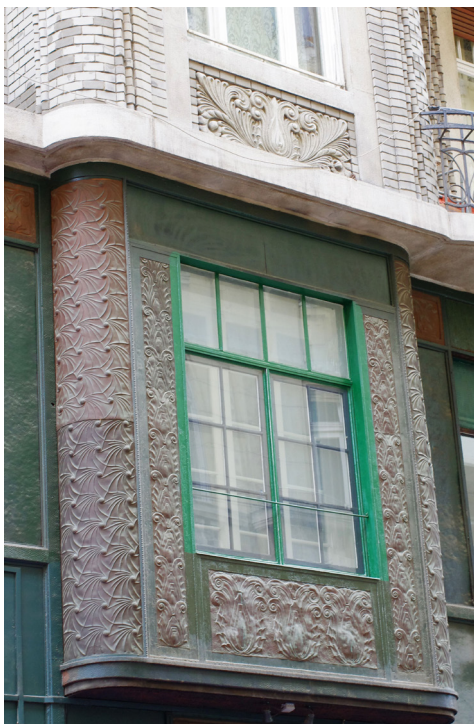
16. ábra: A Károlyi-ház szecessziós fémlemezborítása (a szerző felvétele)
